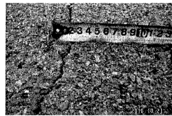
地震直後クラック状況 幅2mm程度
